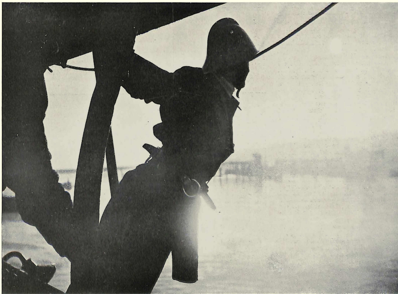
54° Corpo - Napoli - Sospeso nel vuoto, dalle sovrastrutture di una nave, un Vigile è pronto a raccogliere il cordino che gli sarà lanciato dal motoscafo, per trasportare in alto un servizio idraulico.
