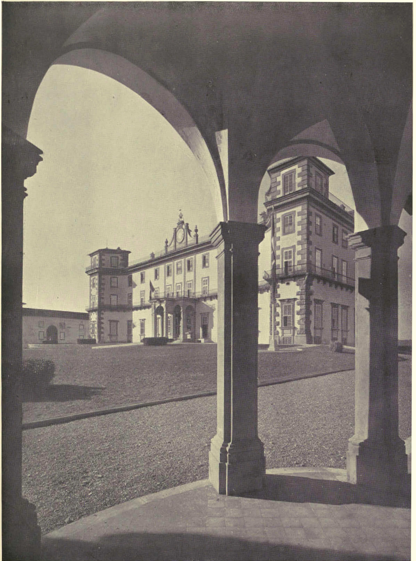
Una superba visione della Casa del Vigile del Fuoco " Tullio Baroni „ dal portico della Cappella di S. Barbara. In fondo, a sinistra, l'ingresso alla Colonia Elioterapica " Carlo Galimberti „
