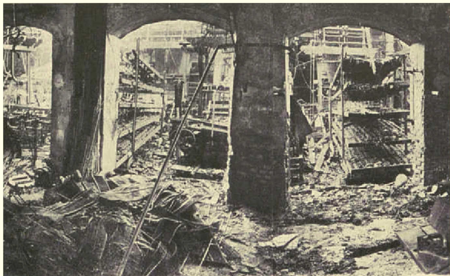
Piano terreno. - Al di là delle arcate si vede come la « Tessitura » sia stata sottratta alla distruzione.
