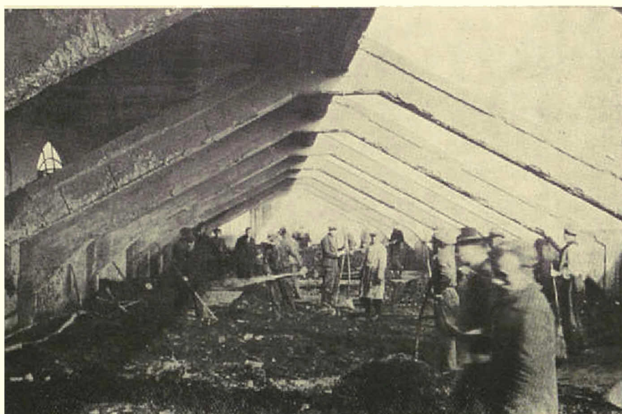
Lo smassamento dei magazzini a incendio finito.
