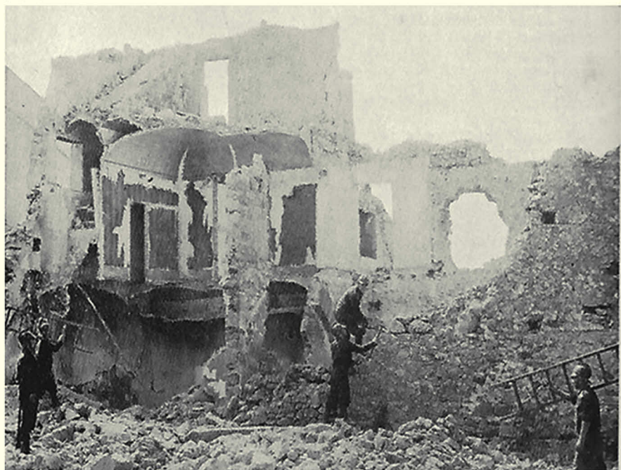
PALERMO - Il crollo di Partinico in cui trovò la morte il Vigile del Fuoco Ferlito.
