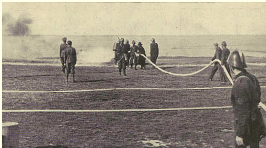
PESARO - Esperimento con bombe al fosforo. Mancato potere di spegnimento con schiuma meccanica, efficace sul liquido infiammabile.
