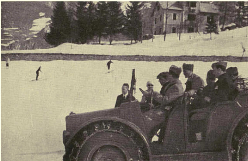
...che trasporta gli uomini fin dove è possibile la marcia degli automezzi.
