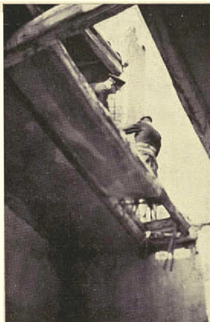
PALERMO - Opere di demolizione in seguito al terremoto.
