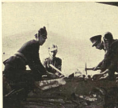
PALERMO - Opere di demolizione in seguito al terremoto.
