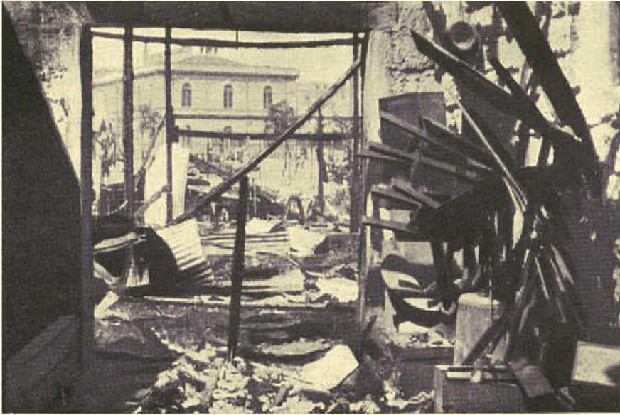
Il cantiere navale Arceri dopo l'incendio - Palermo notte 14 maggio 1929-VII
