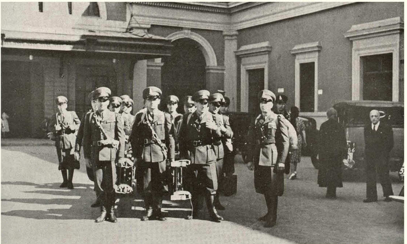
Alla stazione Termini
