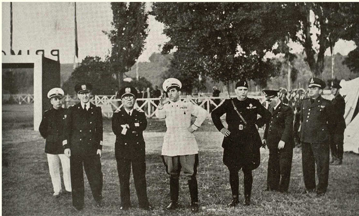
Il Comandante del Campo illustra a S. E. il Prefetto di Roma le caratteristiche tecniche degli impianti
