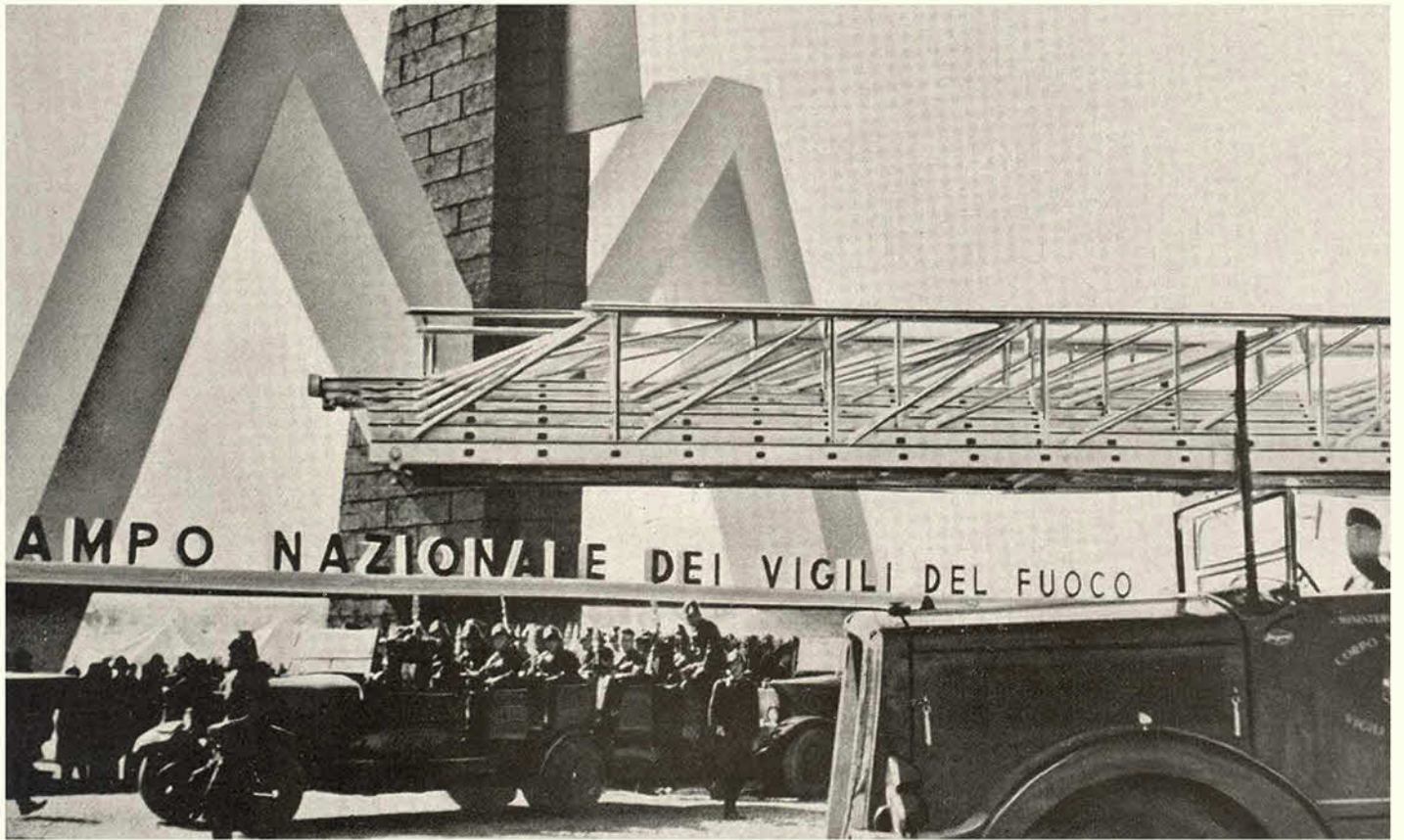
Macchine davanti all'ingresso del campo
