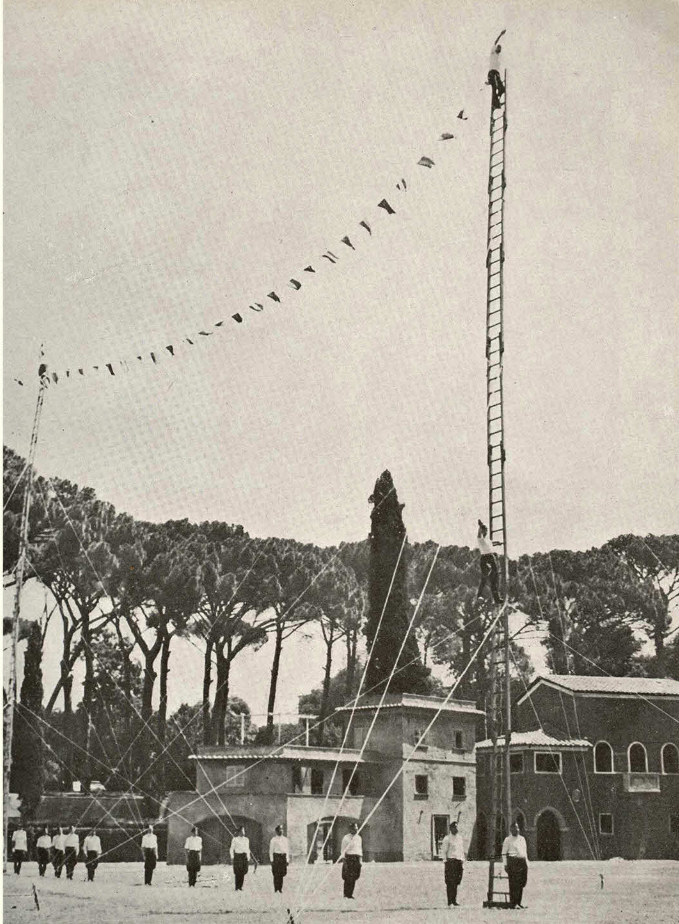
Scale romane controventate: a 24 metri
