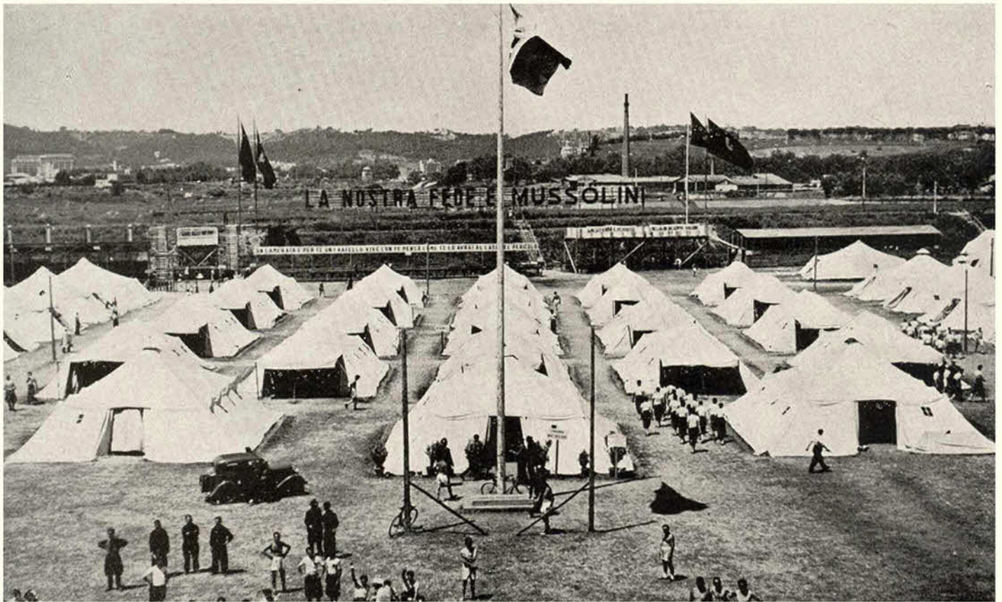
Veduta d'assieme - Al centro la tenda del Comando Battaglioni - Nella linea di fondo da sinistra a destra la dislocazione delle cucine, dei serbatoi dell'acqua, dei lavandini, delle docce e del gruppo elettrogeno
