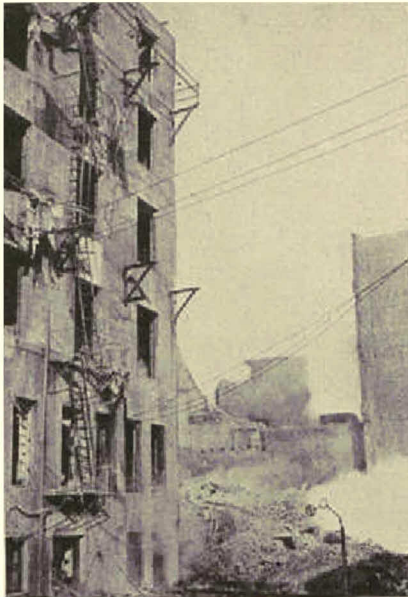
La fronte posteriore dell'albergo. Si vede una serie di scalatte di salvataggio inutilizzata perché i pianicelli dei pianerottoli, fatti di legno, sono stati bruciati
