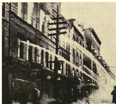
L'Hotel Queen veduto dalla strada; in primo piano a destra il Hesslein Building. Si noti il fascio di conduttori elettrici aerei che ha ostacolato l'avvicinamento delle scale
