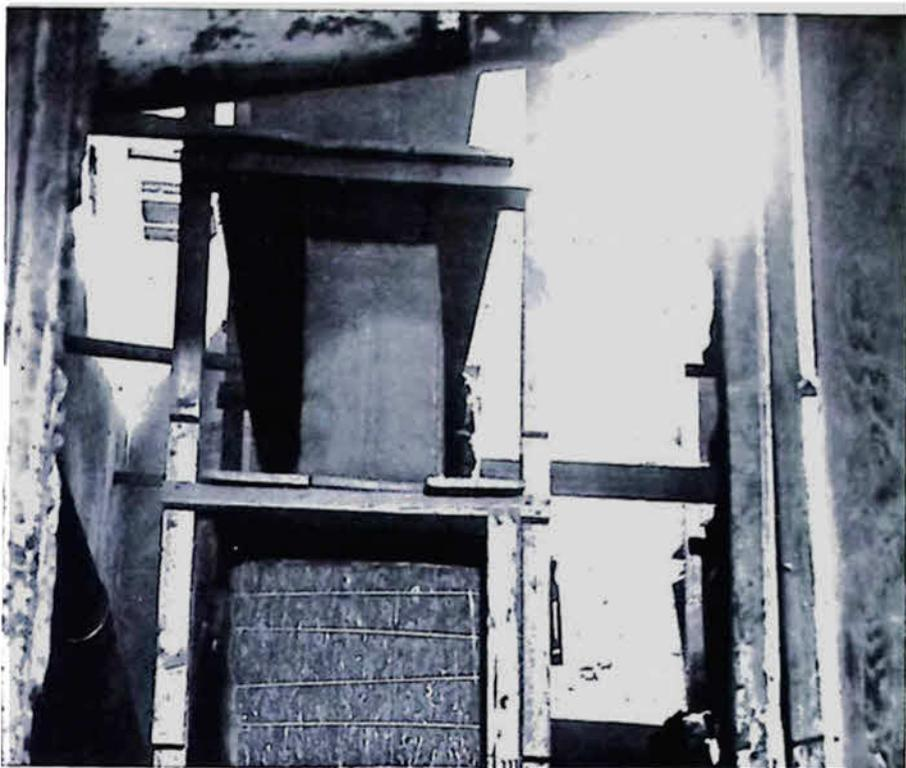
Essiccatoio a fuoco diretto (si noti il tubo riscaldante addossato alle pareti e la vicinanza allo stesso dell'impalcato e dell'infisso in legno del vano d'ingresso)
